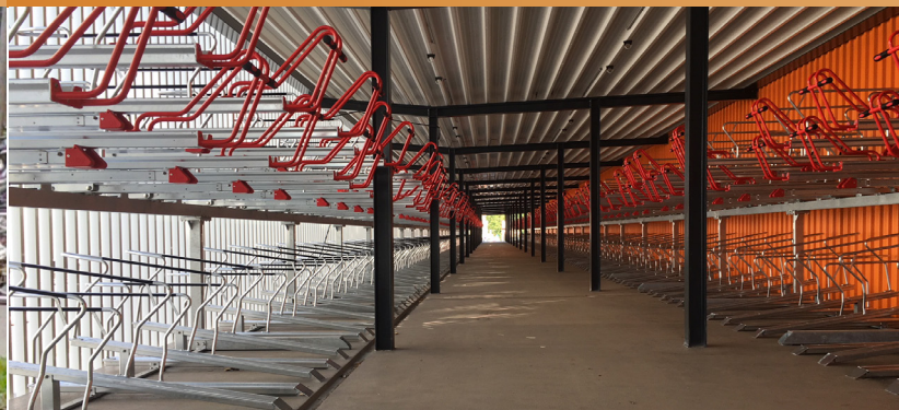
Übersichtliche und ausreichende Abstellplätze im neuen Fahrradparkhaus
