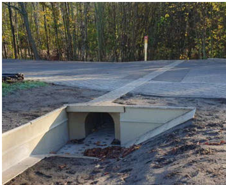
Abbildung 4: Durchlass (Leipzig) Quelle: SIEVERT, 2024 19
