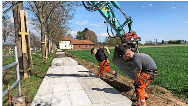
Abbildung 25: Einbau von Wurzelbrücken aus Stahlbeton Quelle: Göttinger Tageblatt, 2024 45
