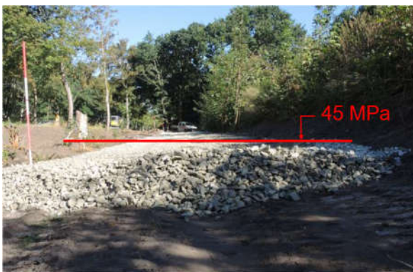
Abbildung 23: Einbau Grobschotter als Unterbau
