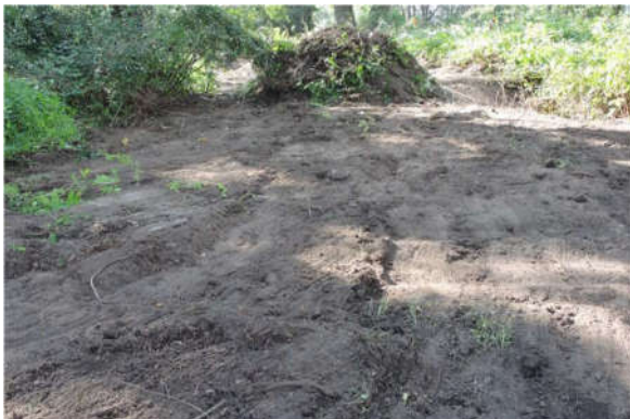
Abbildung 21: Abtrag Oberboden und Bewuchs
