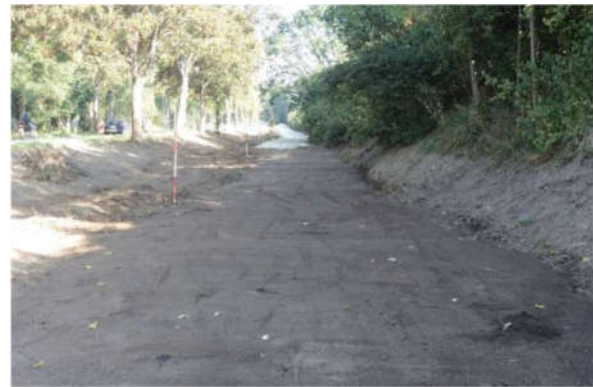
Abbildung 22: Vorbereitete Fläche mit Wurzellockstoff
