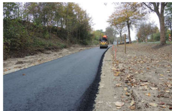
Abbildung 24: Einbau Oberbau nach RStO
